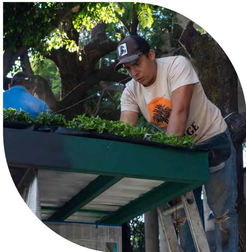
Ambas imagens: Instalação de uma parada de ônibus com teto verde na Avenida 16 de Septiembre, agosto de 2023. © WRI México
