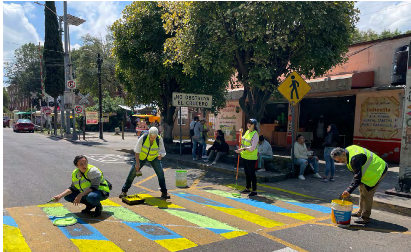
Delimitação de faixas de pedestres na Plaza Revolución, agosto de 2023. © WRI México
