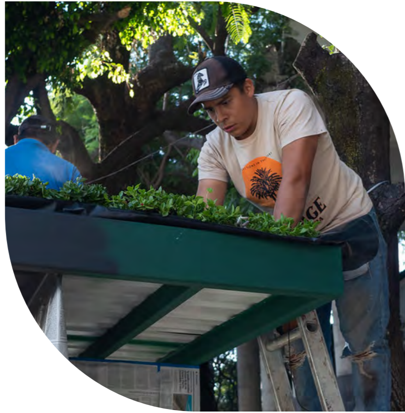
Ambas imágenes: Instalación de una parada de autobús con techo verde en la Avenida 16 de Septiembre, agosto de 2023. © WRI México
