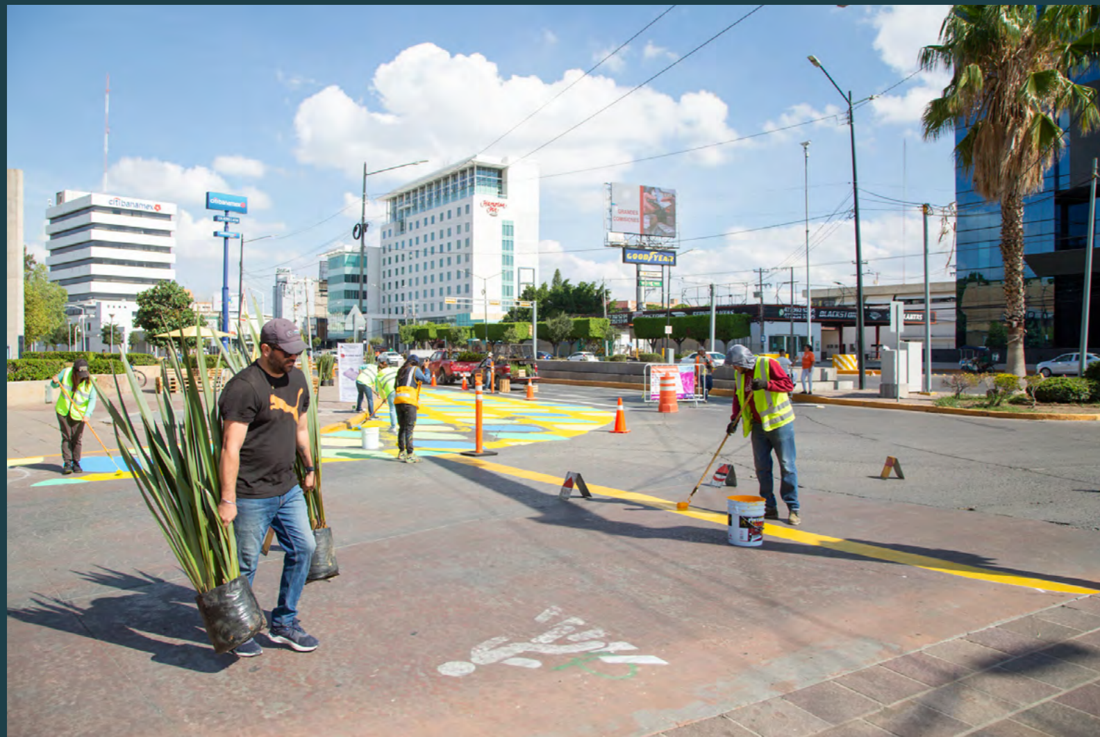
Mejoramiento de espacios peatonales entre Blvd. Adolfo López Mateos, Blvd. Vasco de Quiroga y Calzada de los Héroes, julio de 2023. © WRI México
