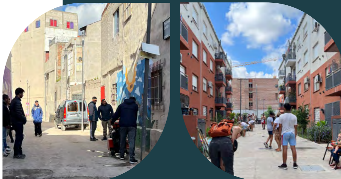
Imagen de la derecha: Iniciativas del LU en ejecución en una calle del complejo de viviendas Papa Francisco, marzo de 2023. © Fernando Almansi / IIED-AL
