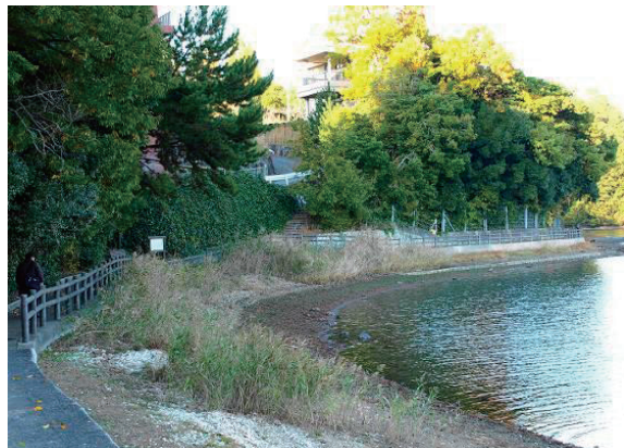
図5.6.10 那波港の状況
