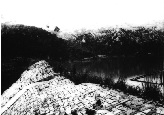
図2.4 相谷堰堤付近 (1889年頃撮影、琵琶湖疏水工事写真帖)
