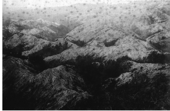
図2.5 相谷堰堤北東の山上より南西方向を撮影したと考えられる写真 (1889年頃撮影、琵琶湖疏水工事写真帖)
