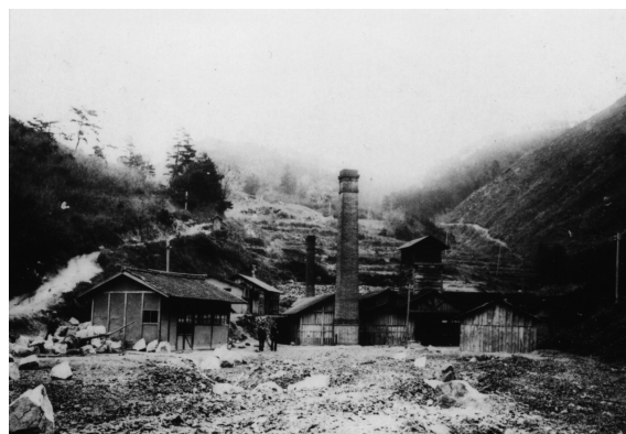
図2.2 琵琶湖疏水第1竪坑付近 (1889年頃撮影、琵琶湖疏水工事写真帖)
