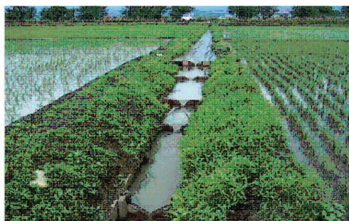
図5.8 排水路堰上げ型の水田魚道、およびその整備場所と整備適地（滋賀県農村振興課）
