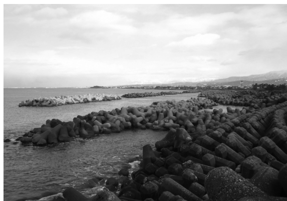
図A.3.10 コンクリート護岸群
